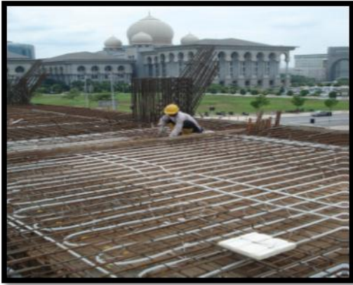
Fig 9: Cooling pipes laid before concrete pour
